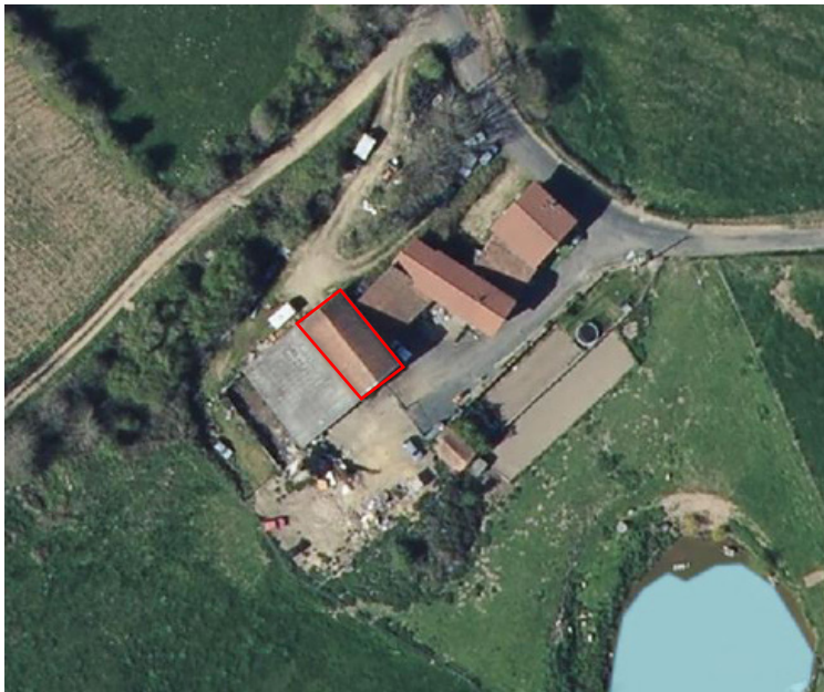
Vue aérienne du bâtiment repéré - Mai 2018
