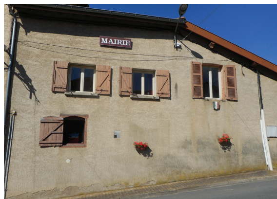
Trottoirs le long de la Mairie
