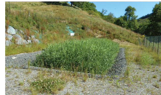
Station d'épuration plantée de roseaux
