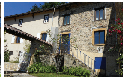
Réhabilitation de corps de ferme
