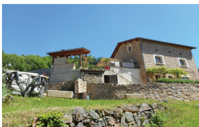
Réhabilitation d'ancien bâtiment en pierre
