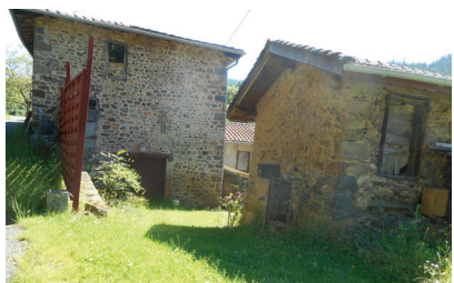
Ancien bâtiment en pierre abandonné
