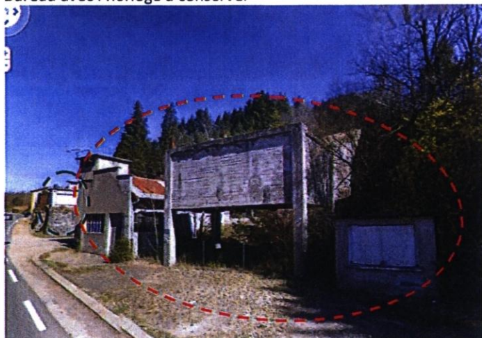
Annexes à démolir
