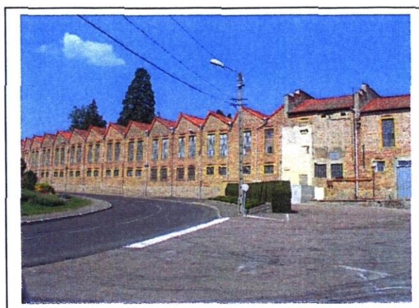
Patrimoine bâti de COURS-LA-VILLE Maison de maître dans le centre Usine textile à toit de sheds.
