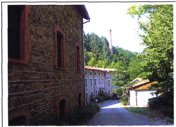
Usine et anciens logements ouvriers de Valissant Bas
