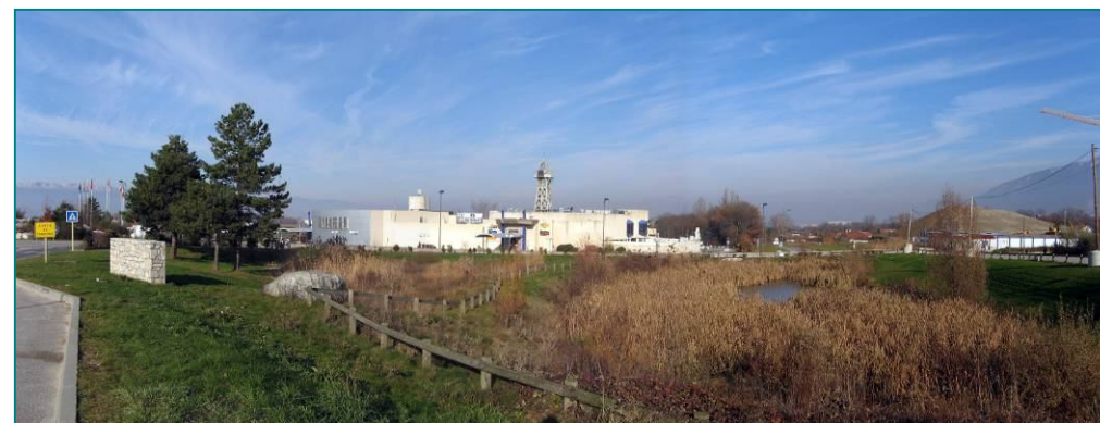
Exemple d'un bassin de retenue d'une zone d'activités à Neydens (74). Les eaux pluviales sont épurées par un filtre à roseaux avant d'être rejetées dans le milieu naturel.
