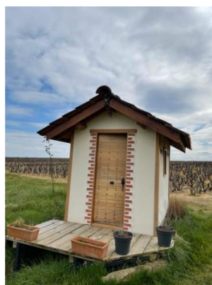
Élément bâti protégé ajouté par la présente modification de droit commun n°3
