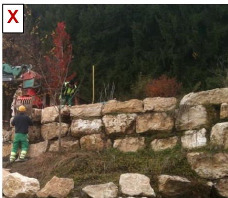
Enrochements de type cyclopéens
