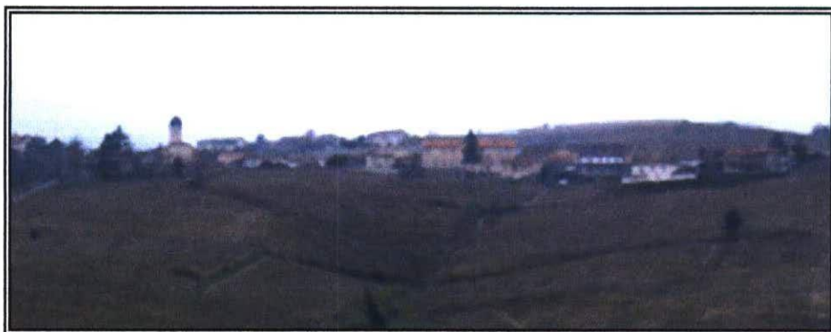
Point de vue sur le bourg depuis le Sud
