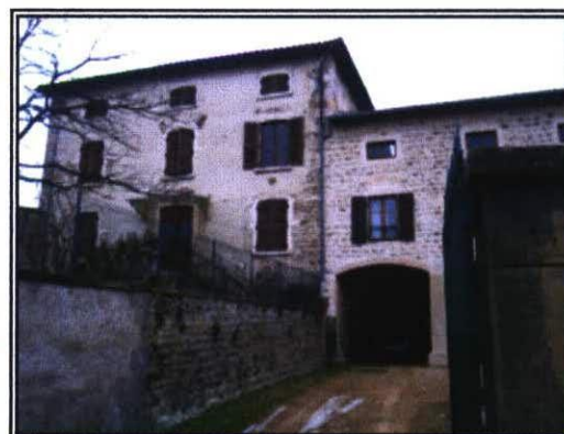
Bâti ancien structuré en cours
