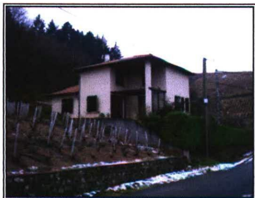
Pavillons récents à proximité du hameau Le Pont
