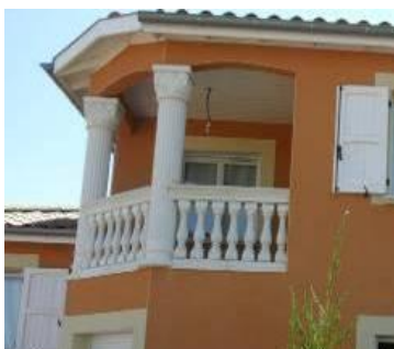
Type de balustres interdits
