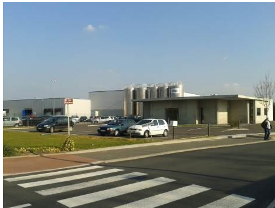
Figure 3: Bâtiment d'activité implanté aux Bageardes.
