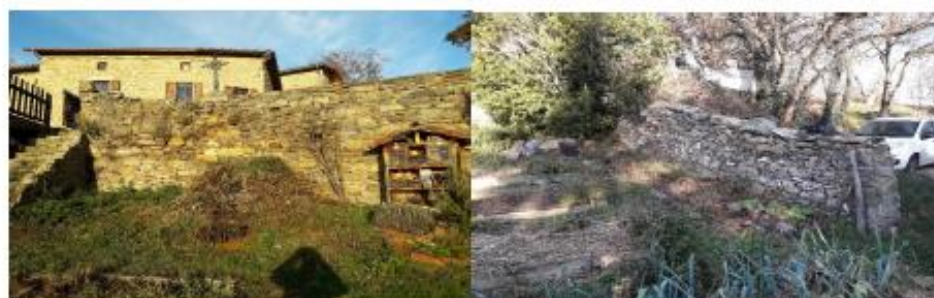
Mur de soutènement voirie communale, mur d'enceinte du jardin privé de Monique et Olivier Huart – parcelle D0454
