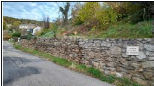
Vue d'ensemble soutènement au départ chemin du bois de Pinloup sous C0686
