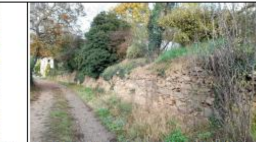
Soutènement long du chemin des Garennes sous C0503/C0506
