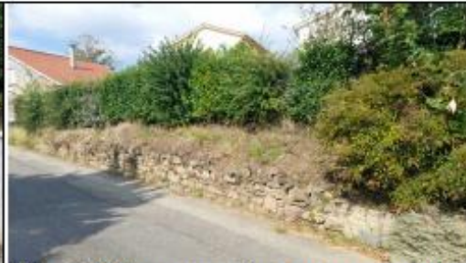
Route de Mornant soutènement sous parcelles A889/A873
