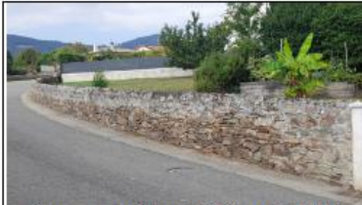
Mur en arrondi route de Mornant A1016 (partiellement soutènement-principalement limite RD)
