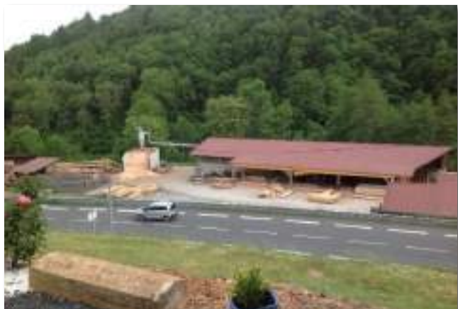
Scierie - Visite de site
