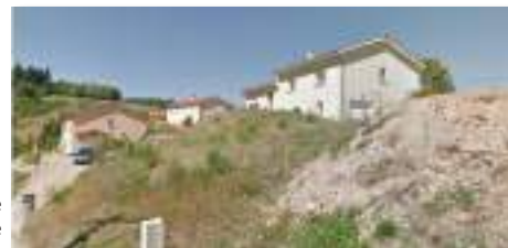
Développement pavillonnaire très peu dense
