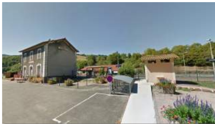
Gare de Chamelet Source : Visite de site
