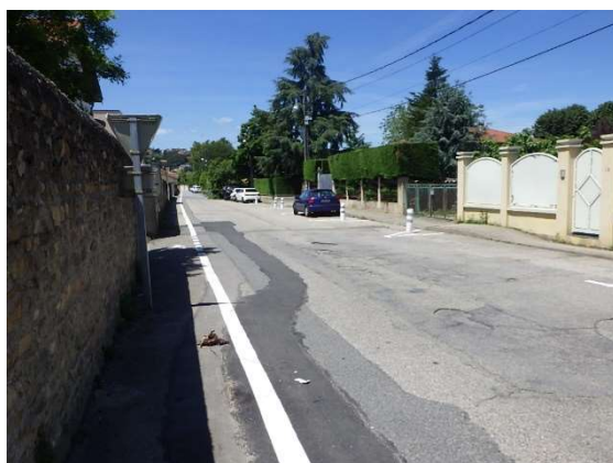
Rue du Presbytère – vue vers l'ouest
