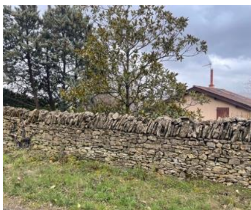
Chemin des crêtes : Parcelle A1520 mur en pierre et banc en pierre (public)
