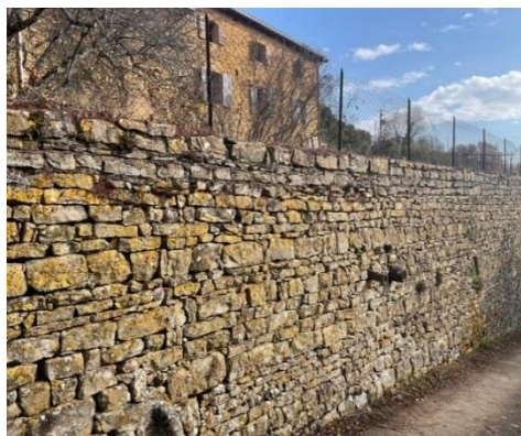
Ruelle du Bas-Pérou : murs en pierre : parcelle A1846, A0477
