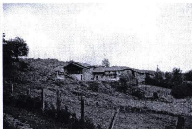
Hameau Les Vaillants dont une partie des bâtiments est en cours de rénovation.
