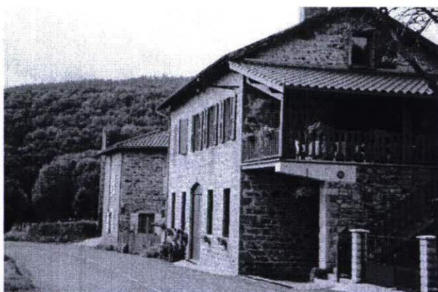
Maison isolée le long de la R.D. 23 avant la Verrière. Rénovation ayant conservé les caractéristiques d'origine du bâtiment, mis à part le balcon, la montée d'escalier et l'avant-toit. L'utilisation de matériaux traditionnels (pierres de pays, bois, tuiles canal rouges) permet l'intégration paysagère de l'extension du bâtiment.
