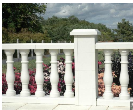
Type de balustres interdit
