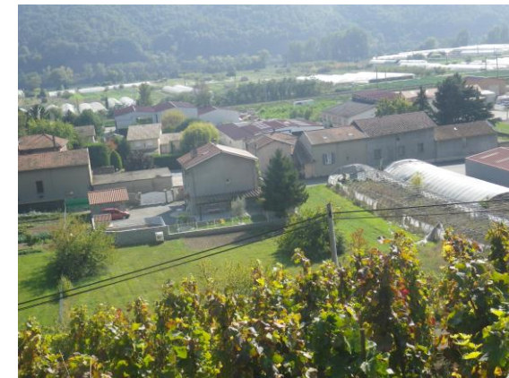
Vues depuis la route de Boucharey
