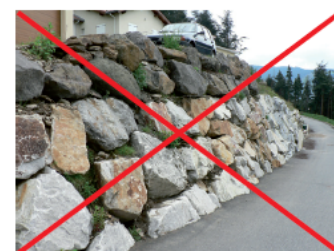
Exemple d'enrochements de type cyclopéen
