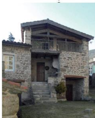
Exemple de débord de toiture
