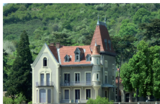
Exemple de toiture «atypique»
