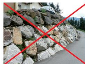
Exemple d'enrochements de type cyclopéen
