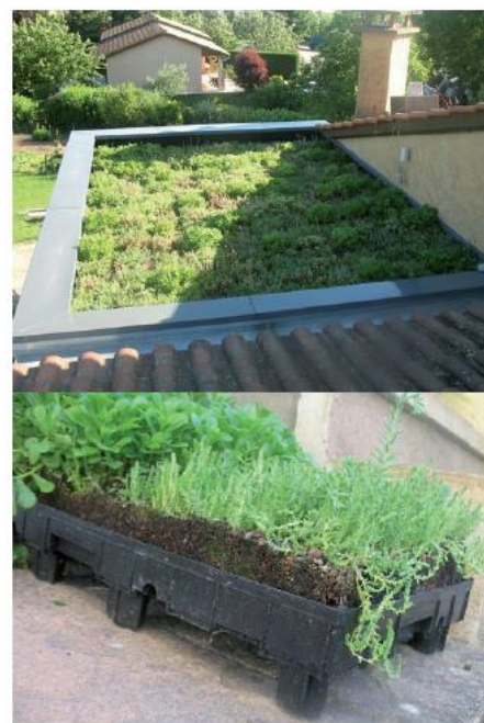
Exemple de toiture-terrasse végétalisée et bacs pré-cultivés
