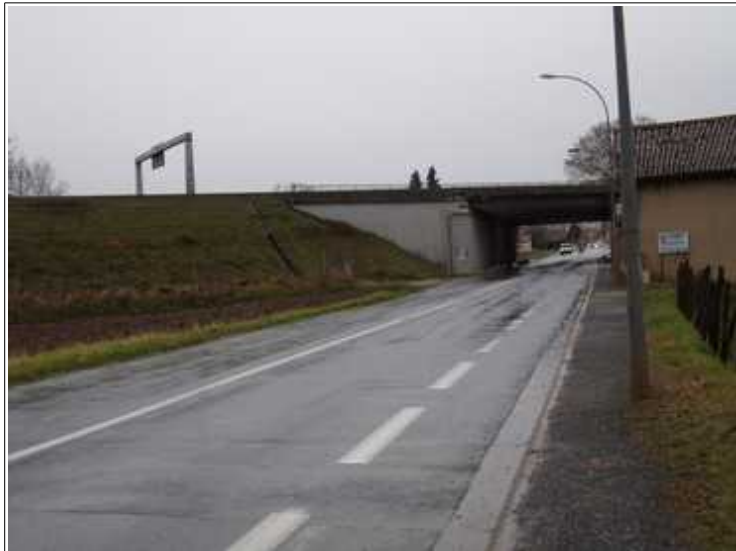
Photo 5 : remblai de l'autoroute A6 (talus sud-est) au lieu-dit Pré-Lachaine.
