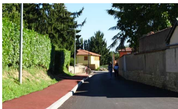
Trottoir aménagé rue Cornet
