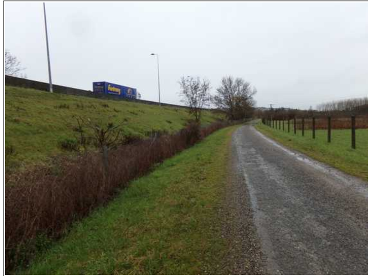
Photo 9: remblai de l'autoroute A46 (talus est) au lieu-dit La Grande Bordière.
