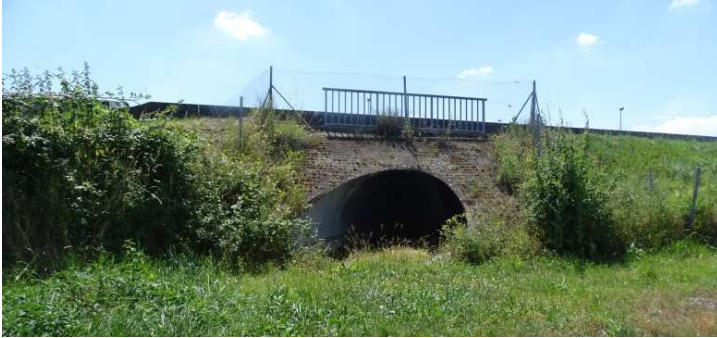
Ouvrage sous l'A 46
