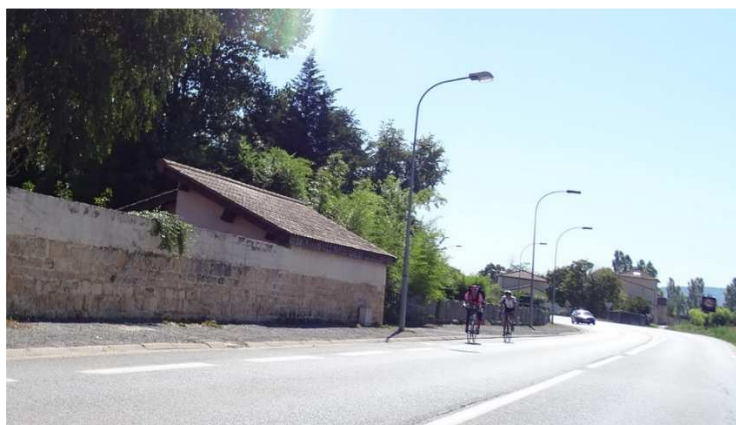
Bande cyclable le long de la RD 51 au Nord du bourg
