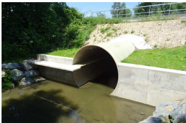
Franchissement de l'A 46 par le Bief
