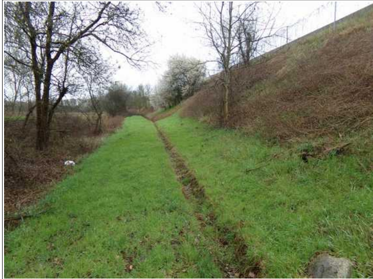
Photo 7 : remblai de l'autoroute A6, au nord du franchissement de la RD51 (talus ouest).
