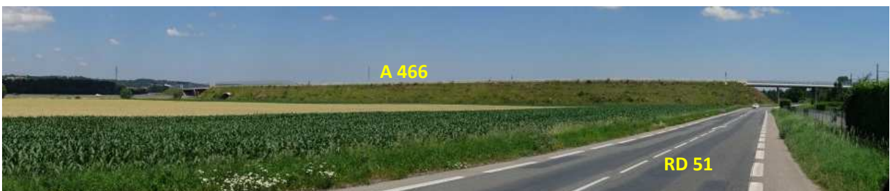
Topographie bouleversée par les infrastructures comme l'A 466
