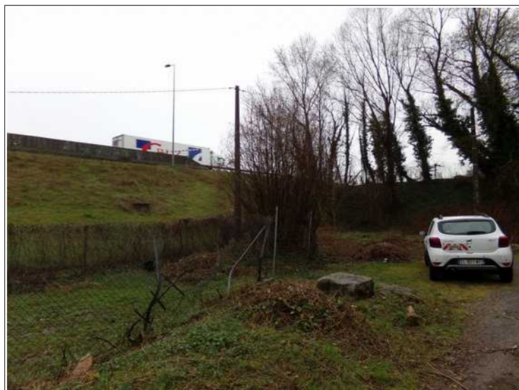
Photo 10: remblai de la voie descendante de l'autoroute A46, en limite communale nord de la commune.
