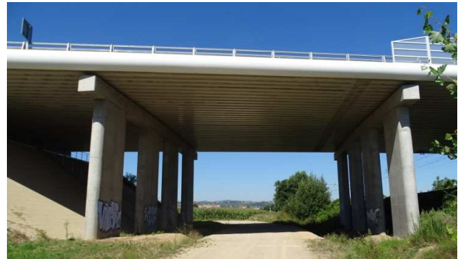
Franchissement de l'A 466
