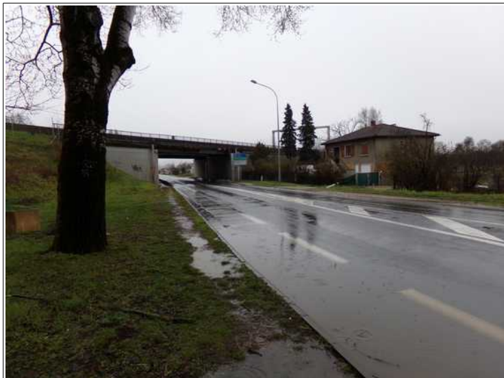
Photo 6 : remblai de l'autoroute A6 (talus nord-ouest) au lieu-dit Pré-Lachaine.
