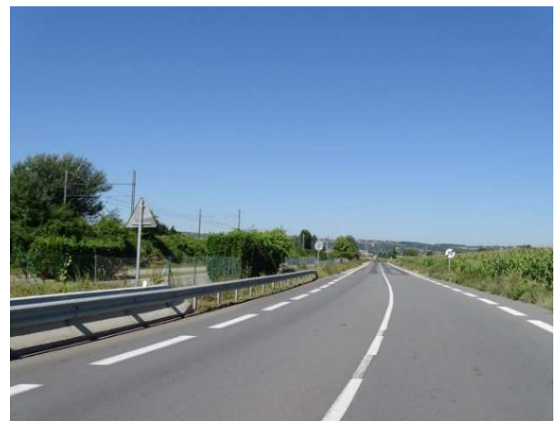
Profil de la RD 51 en arrivant dans le centre bourg
