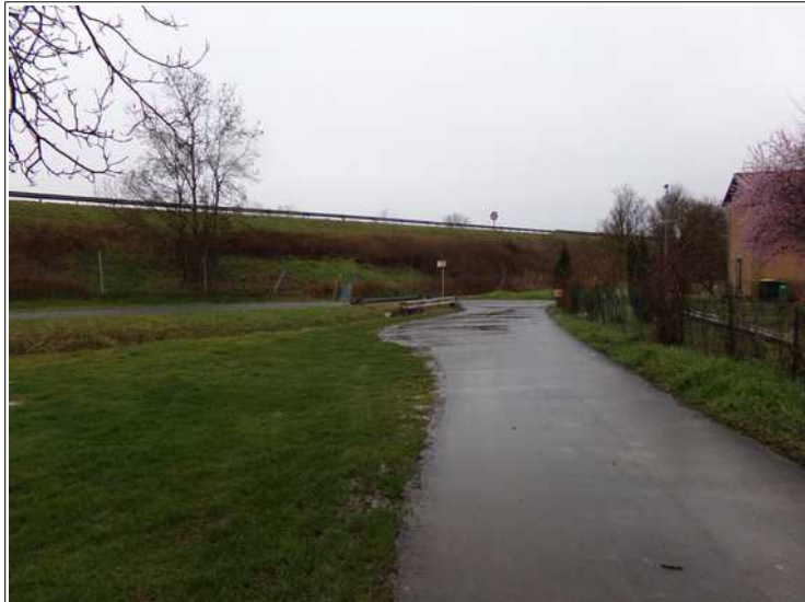
Photo 3 : remblai de l'autoroute A6 (talus sud-est) au lieu-dit Le Pilon.
