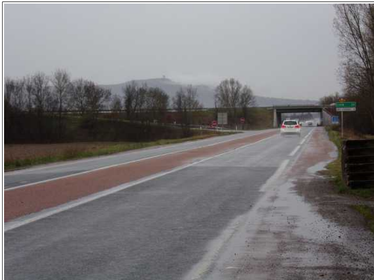
Photo 4 : remblai de l'autoroute A6 (talus nord-ouest) au lieu-dit Le Pilon.
