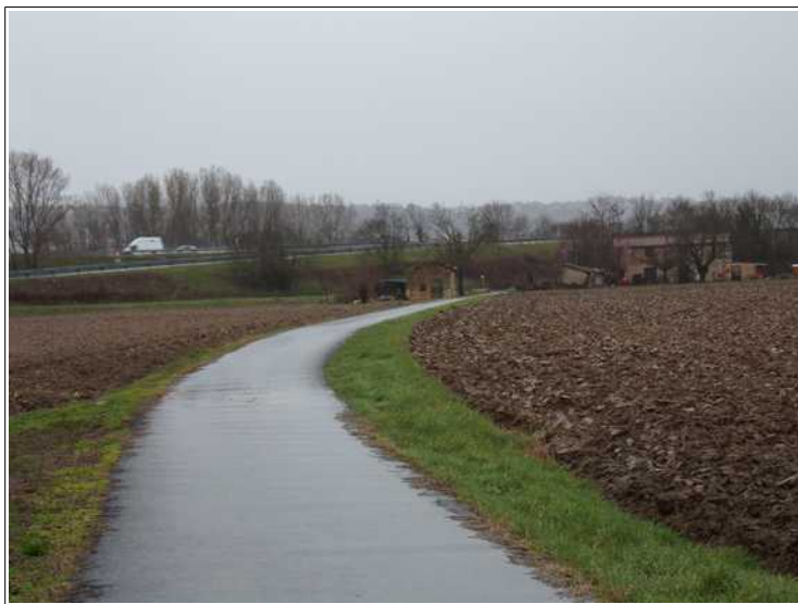
Photo 2 : remblai de l'autoroute A6 (talus sud-est) au lieu-dit Le Pilon.
