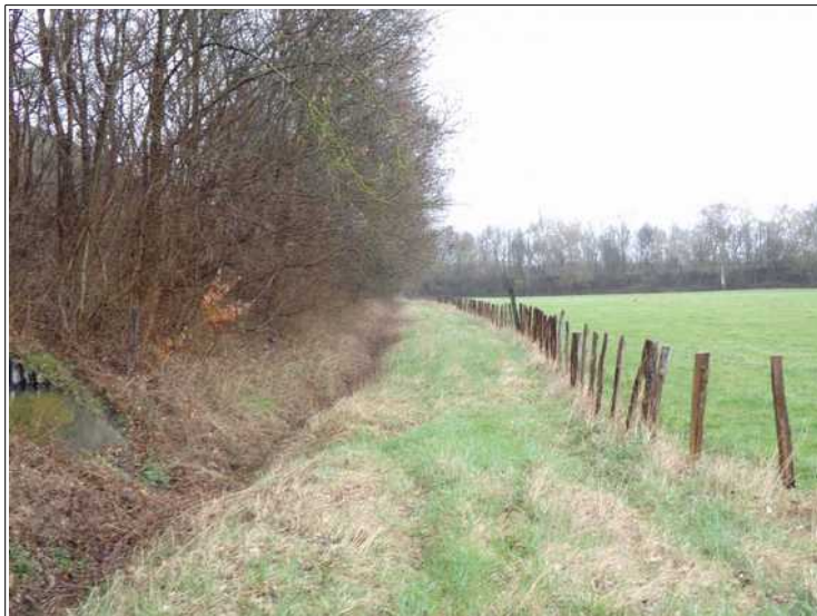
Photo 8 : remblai de l'autoroute A6, au nord du franchissement de la RD51 (talus est sur la gauche de la photo) et talus de la voie ferrée en arrière plan.
