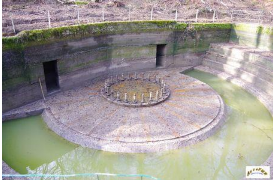
La cuve du canon en 2017 au début de l'opération de réhabilitation. Les deux ouvertures dans le mur du fond donnent sur deux abris pour les servants.
