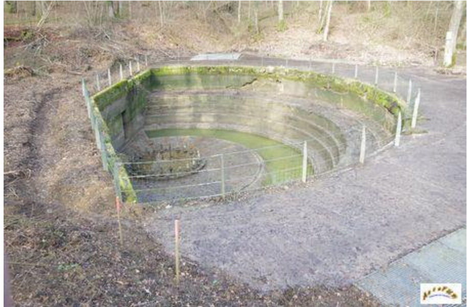
La cuve en 2017 après le pompage de l'eau
