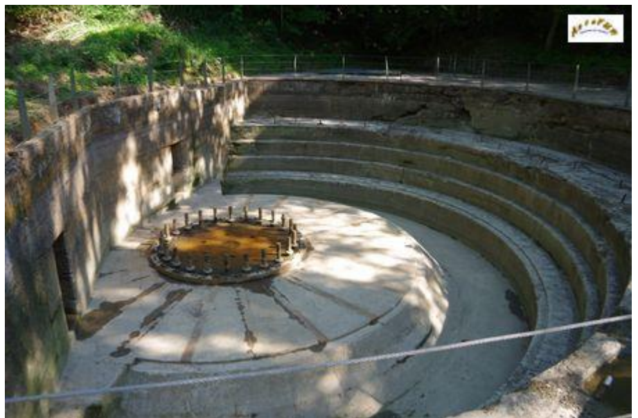
Le site a bénéficié en 2017 d'une opération de réhabilitation
