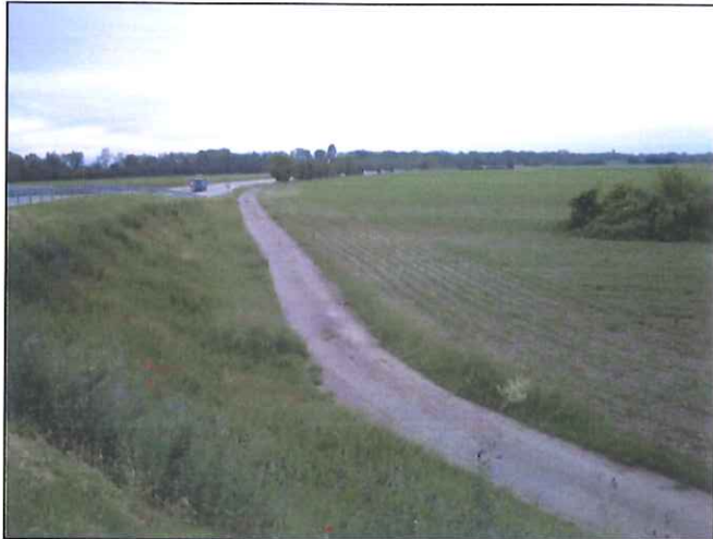
Vue depuis le giratoire sur la RD 415
