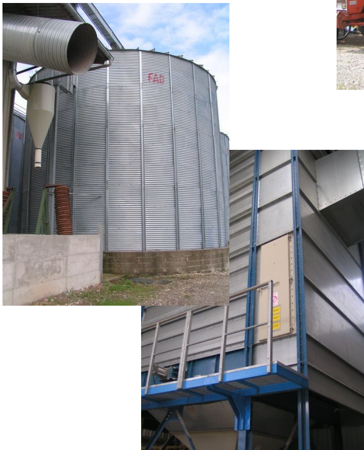
Installation de stockage (droite) et de séchage (gauche) du grain
