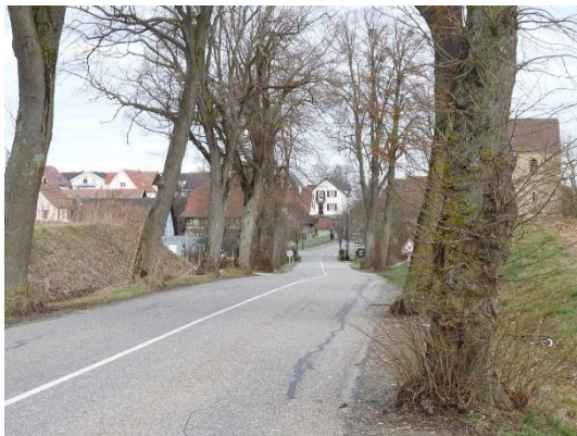
L'aspect rural conservé à l'entrée sud
