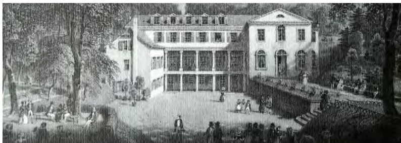
Le bâtiment thermal érigé par De Gonzenbach vers 1850
