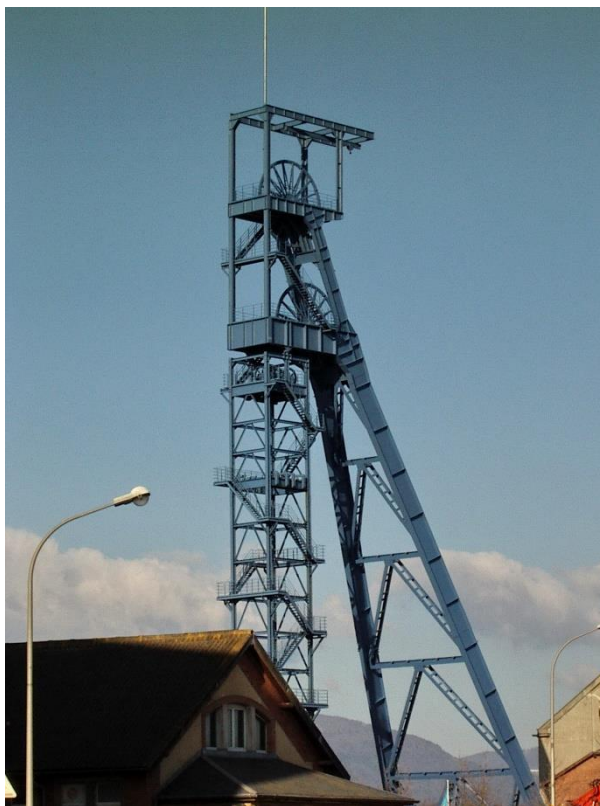
Illustration 47 : Chevalement du puits de mine (carreau Théodore)
