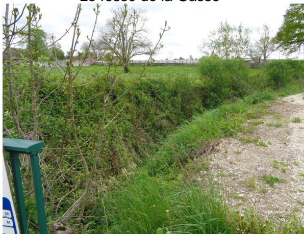
Le fossé de la Gasse
