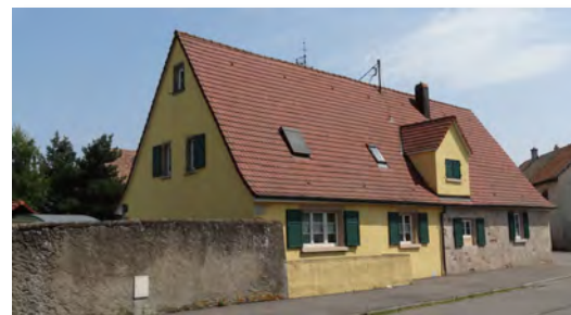
Autre exemple de maison à toit à long pan restaurée
