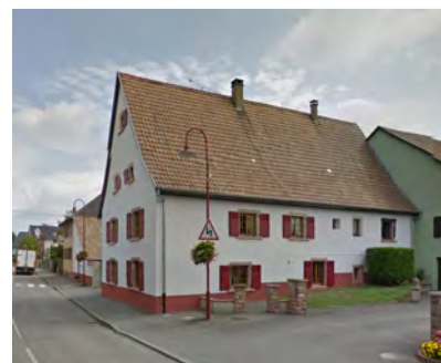
Maison restaurée à toit à longs pans sur la Grand-Rue
