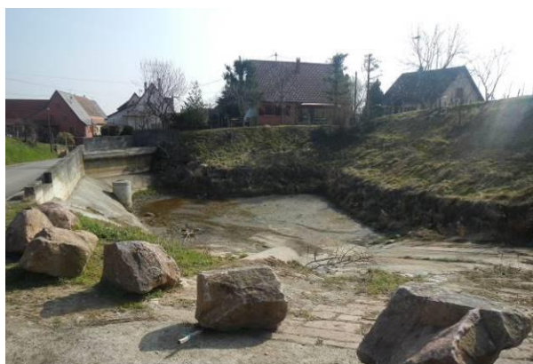
Bassin de rétention rue du Schauenberg
