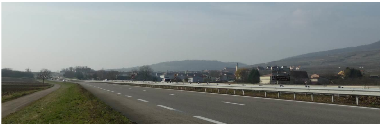
Passage de la RD83, en 2x2 voies, à l’est du village
