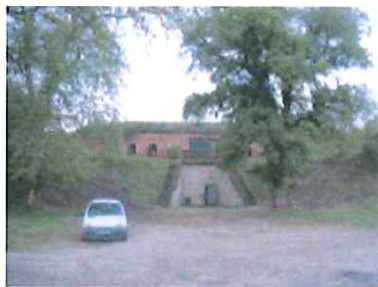
Casemate cité Suzonni avec abords non aménagés
