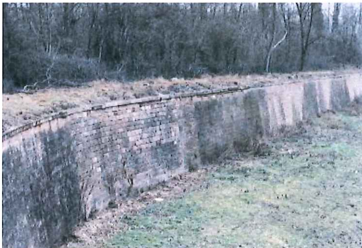
Le mur de contre-escarpe de l'enceinte de combat
