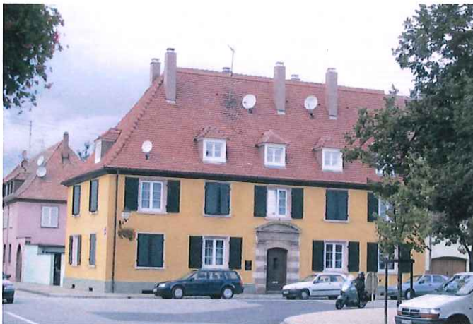
La maison des Officiers
