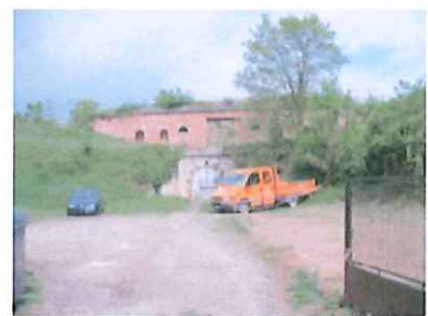
Casemate rue des Déportés avec abords non aménagés
