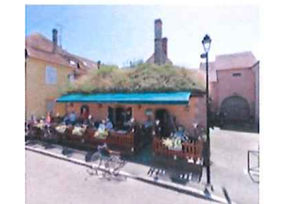
Un bâtiment militaire sans toiture a été reconverti en commerce
