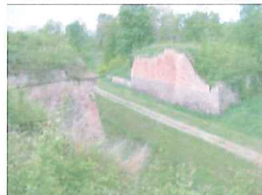
Les murs de soutènement cloisonnent l'espace
