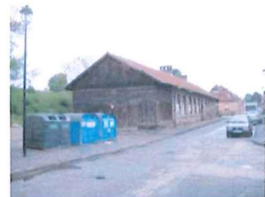
Bâtiment ancien en bordure de la Place de Strasbourg
