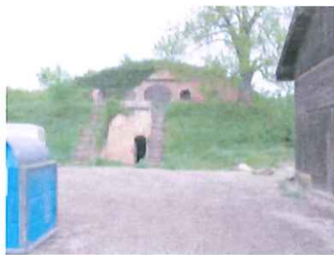
Casemate cité Suzonni avec abords non aménagés
