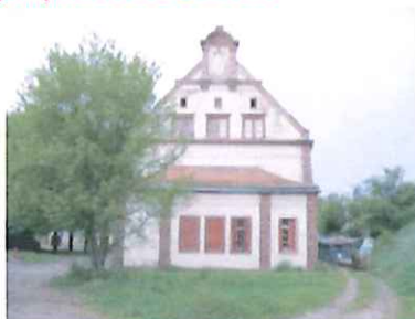
Extrémité de la caserne Suzonni en bordure du talus du rempart
