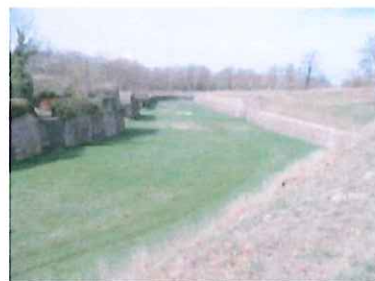
Des vues depuis le haut des remparts permettent d'appréhender ce vaste espace
