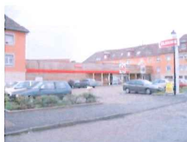
La rue du 28ème RIF est animée par une surface commerciale
