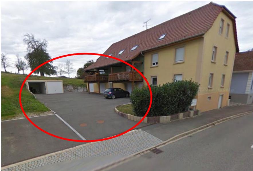
Cour et garage privatif au sein d'un collectif de 6 logements – Rue de Durlinsdorf
