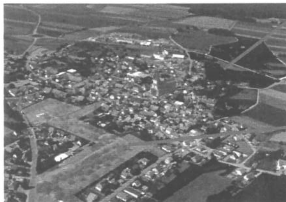
Extensions non réfléchies dans le long terme. Les zones à urbaniser sont loin du centre du village. Le village s'étale dans les champs sans cohérence avec l'existant. C'est un gaspillage de l'espace qu'il sera difficile de réintégrer au village-centre dans le futur. Un deuxième village naît.
