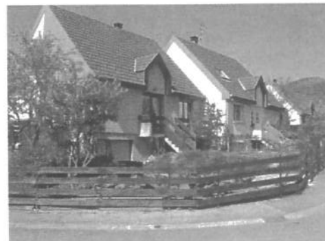
Clôture en bois de lattes horizontales.
