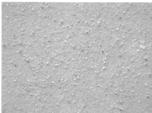
Enduit à la chaux brossé pour faire ressortir les gravillons de sable
