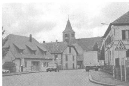
Rue de Guebwiller, la mairie est située à droite
