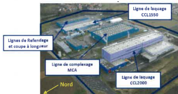
et Usine 2 site d'exploitation depuis 70', à l'entrée sud du village
