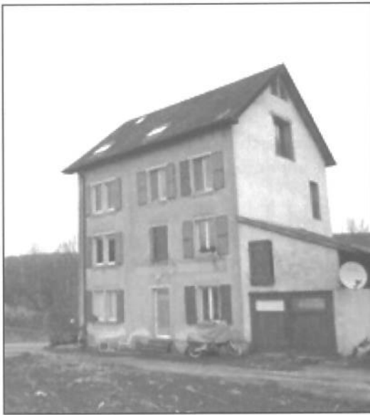
Ce bâtiment à 3 niveaux habitables est le dernier en direction de la Suisse. Il s'agit d'une ancienne douane construite au début du 20 e siècle par les Allemands, et transformée en logements.
