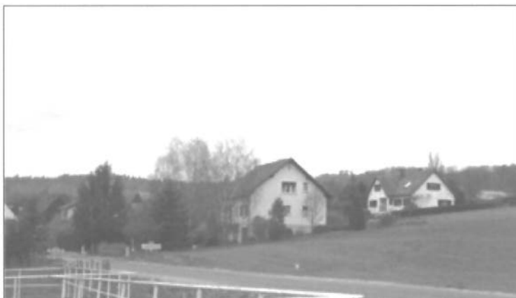
Le front urbain qui s'est développé récemment en bordure de la route départementale et qui marque l'entrée Est de l'agglomération est de type pavillonnaire diffus. La transition entre l'espace naturel et l'urbanisation n'est plus assurée par des arbres fruitiers.
