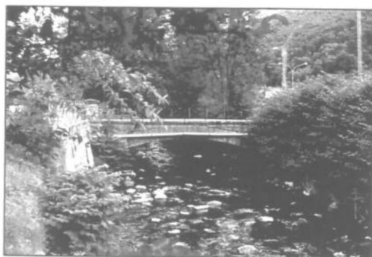
Le cours de la Lauch en limite de l'agglomération
