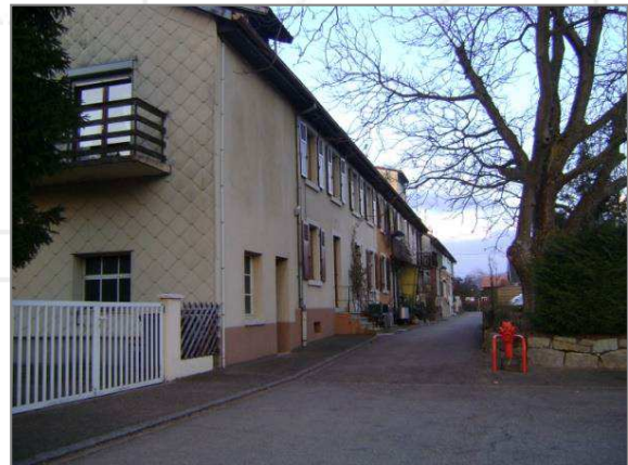
Continuité bâtie (Rue de la Cité)
