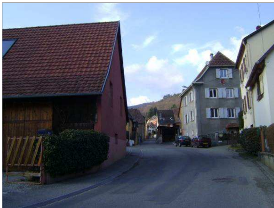
La rue du docteur Albert Schweitzer permet de desservir les constructions du fond de vallon
