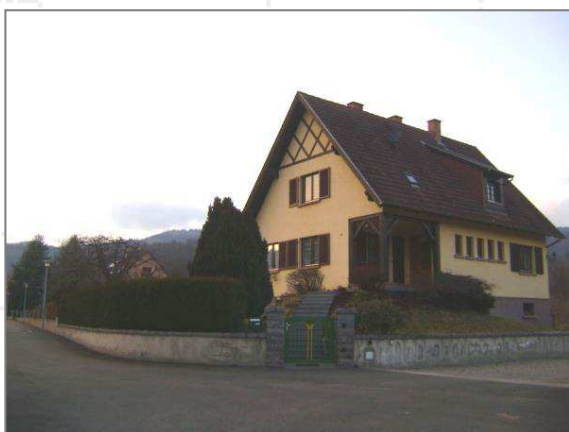
Implantation typique en milieu de parcelle (rue du Canal)
