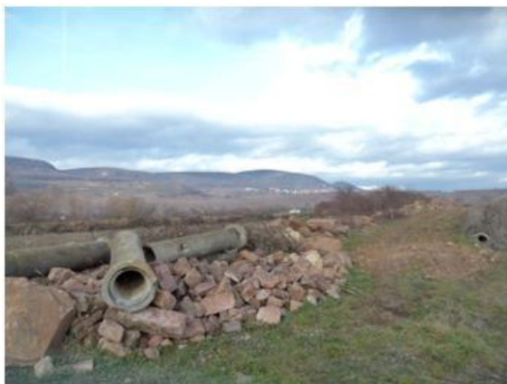
Remblais et dépôts de matériaux
