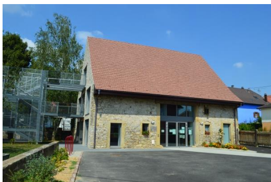
Le bâtiment d'accueil de loisirs « La Grange aux Lutins »
