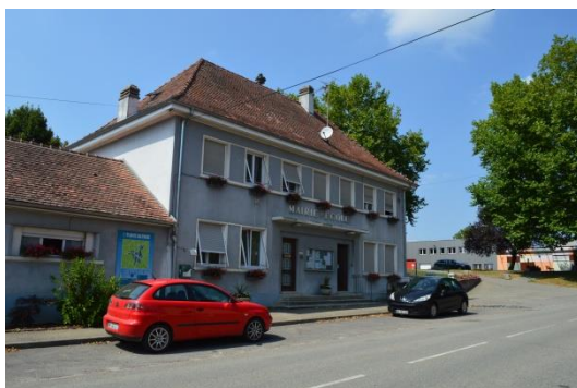
La mairie et l'école (la salle polyvalente apparaît au fond à droite)
