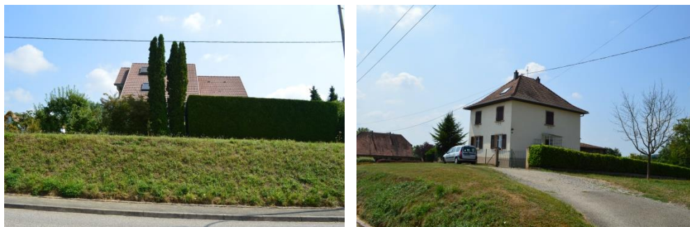
Constructions implantées en surplomb de la voie de part et d'autre de la RD
