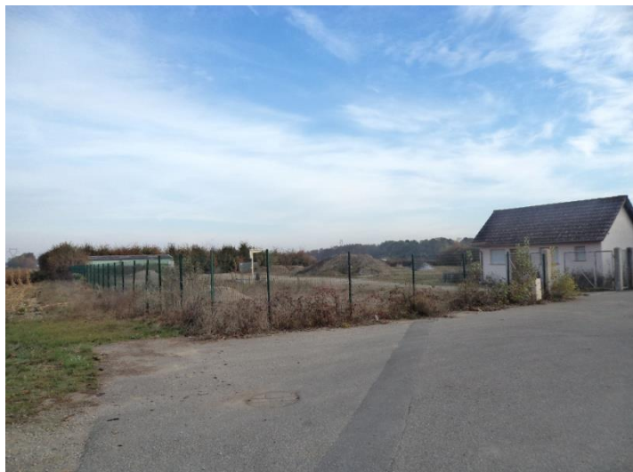
Le site de l'ancienne station d'épuration
