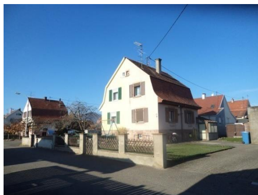
Maison de type 2 remaniée
