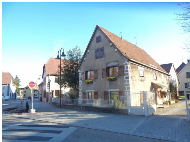
Maison 2, rue du Vieil Armand
