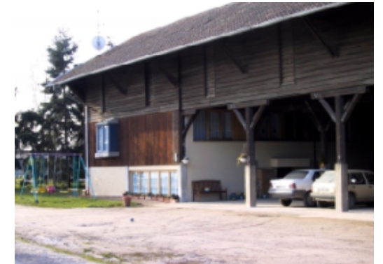
RETRUCTURATION D'UNE GRANGE A STOTZHEIM (ALSACE) – M. ANDREW
