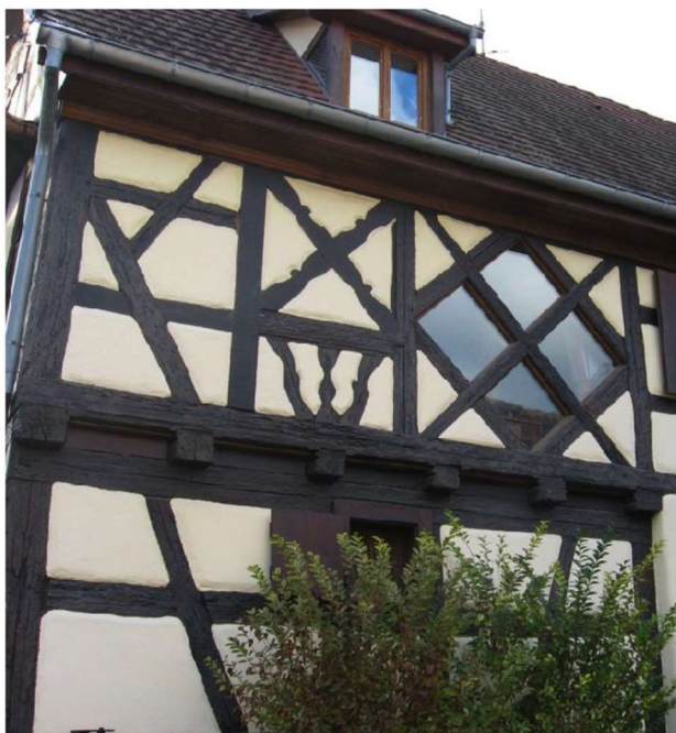
Ouverture respectant la configuration originelle des pans de bois
