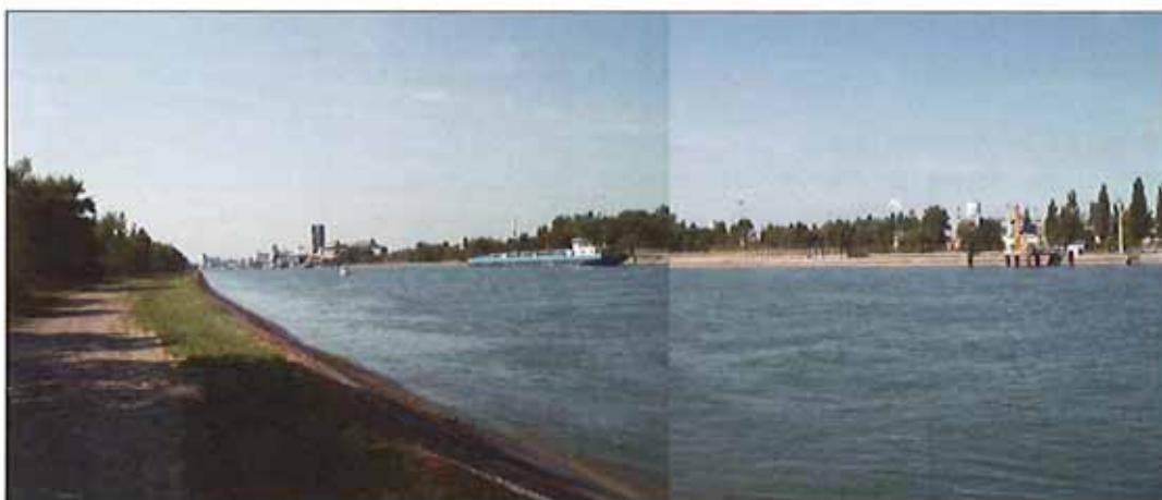
Le Grand Canal d'Alsace au droit de BANTZENHEIM
