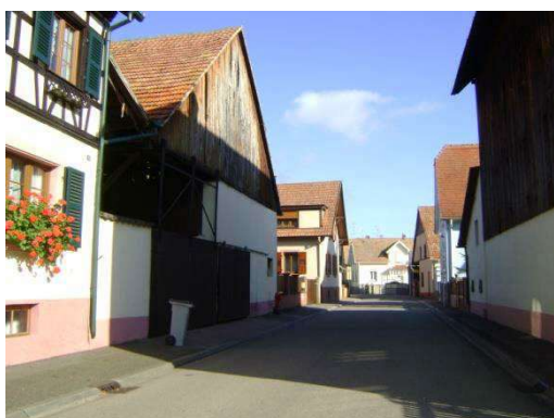
Les constructions se sont implantées en limite d'emprise publique, formant une continuité bâtie (rue de l'Ecole)
