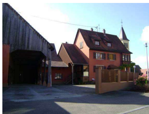
Construction rénovée (rue Principale)
