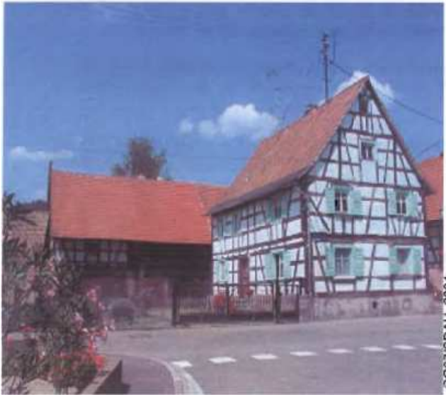
Exemple du patrimoine architectural traditionnel de Wingen.
