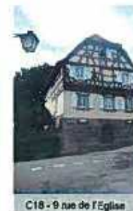
C18 - 9 rue de l'Eglise
