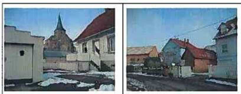
Photo 25 a et b: De nouvelles constructions, qui s'intègrent peu à l'existant
