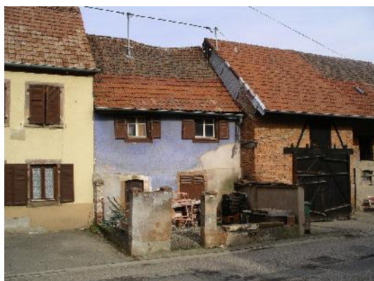
Construction de limite latérale à limite latérale Rue de l'Evêque de Lichtenberg
