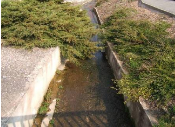
Aménagement du lit du Bitzenbaechel dans la traversée de Still
