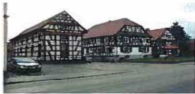
Photo 4 : Grange-séchoir à tabac à Surbourg
