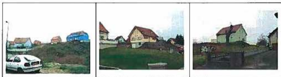
Figure 44 : Assemblage indiquant le non-respect de la topographie
