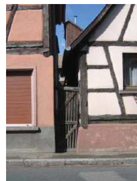
Parfois, les pignons sur rue s'appuient sur une limite séparative au moins, en respectant une distance de l'ordre de 50 cm, une cloison par feux pour permettre le débord de toiture.
