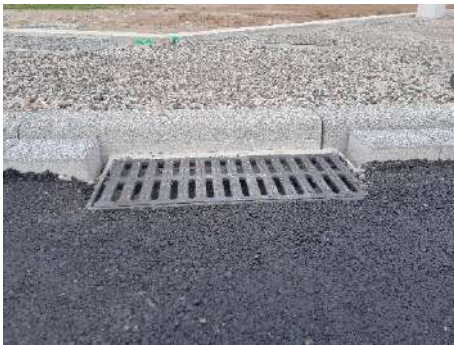
Photo 13: Exemple d'avaloir non sécurisé : les amphibiens parvenus sur la chaussée longent le rebord du trottoir et chutent dans le regard.
