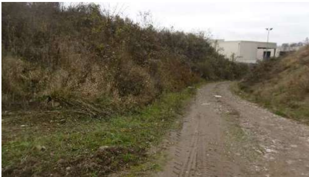
Ronciers sur les talus du stockage d'amiante
