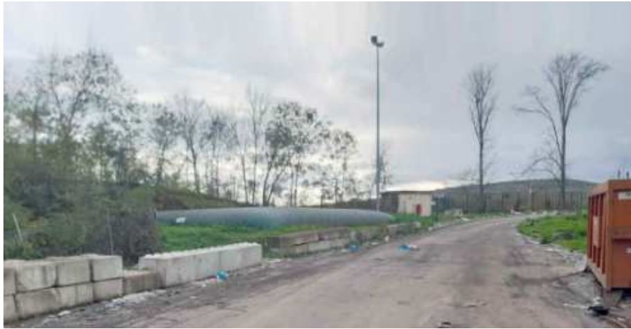
Bâche de protection incendie actuelle
