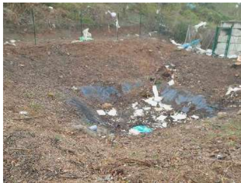
Photo 2 et suivante : Bassins de rétention 1, 2 et 3.
