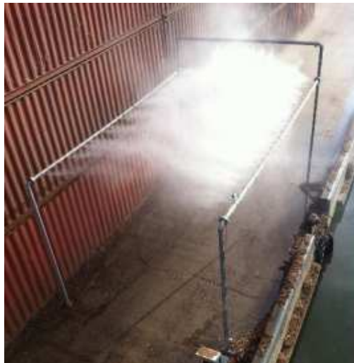
Structure intégrée au broyeur
