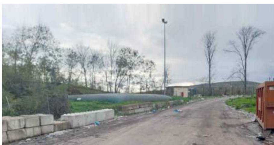
Bâche de protection incendie actuelle
