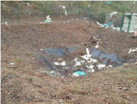
Photo 8 et suivantes : Bassins de rétention 1, 2 et 3.
