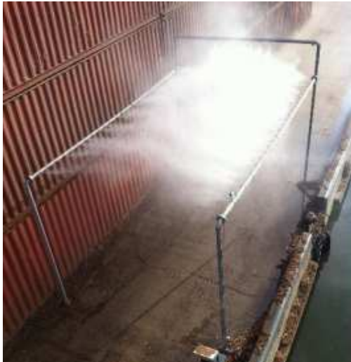
Structure intégrée au broyeur
